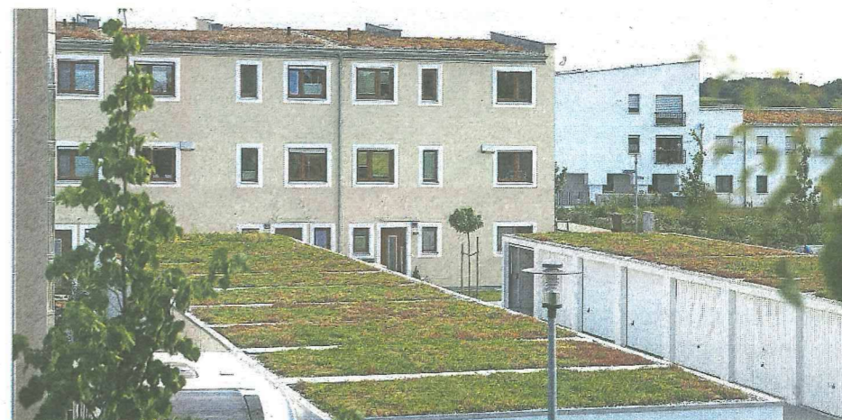
→ Grün auf Flachdächern ist in Neubaugebieten wie in Burgweinting eine häufig genutzte Möglichkeit, zur Klimaresilienz beizutragen
